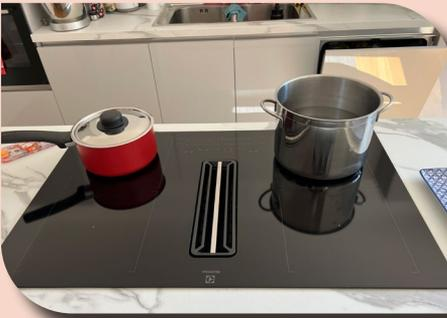
Piano cottura ad induzione con aspirazione aria dal basso, sostituisce la tradizionale cappa aspirante.
