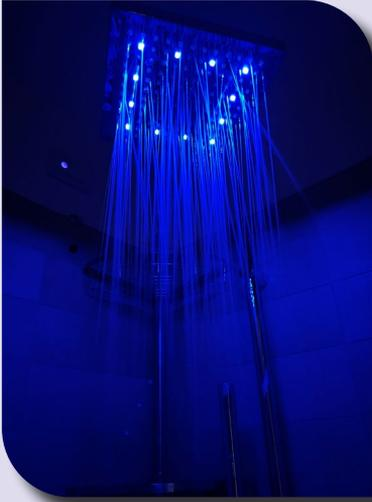
Doccia con led integrati che cambiano colore a seconda della temperatura dell'acqua, non necessitano di alimentazione elettrica.
