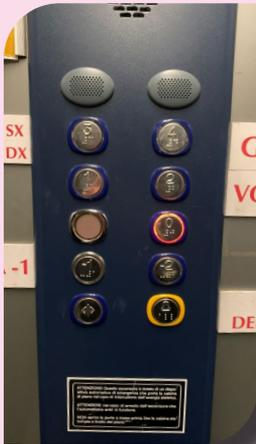
Pulsantiera ascensore perfettamente accessibile ai non vedenti perché con tasti in rilievo con numero anche in braille ma pressoché inaccessibile alle persone ipovedenti perché con numeri privi di contrasto e non illuminati.
