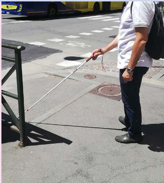
FOTO 2. Scivolo allineato al percorso pedonale
