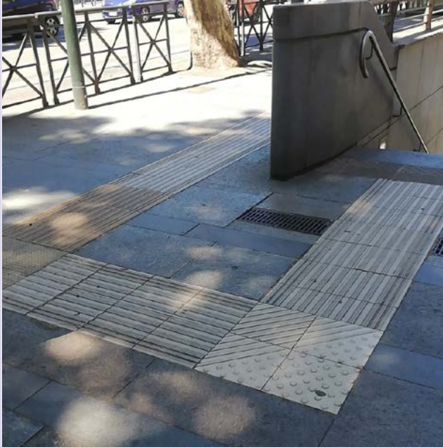
Esempio di ingresso alla metropolitana segnalato da percorso LVE
