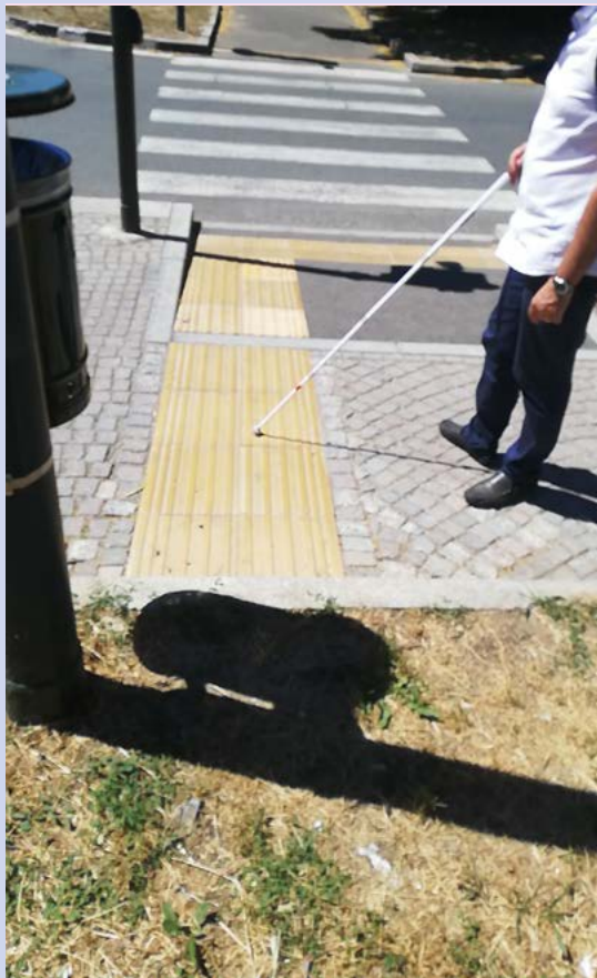
FOTO 3. Scivolo “lontano” dal marciapiede e dotato di una segnalazione LOGES rettilinea che conduce sul passaggio pedonale. Gli ipovedenti sono facilitati per l’orientamento anche in condizioni di buio e maltempo. Gli anziani con la borsa della spesa al traino, un tutore di appoggio e con poca vista si sentono più tutelati ed aiutati nel loro diritto alla mobilità in autonomia. L’isola salvavita al centro strada è fondamentale per la sicurezza di tutti i pedoni
