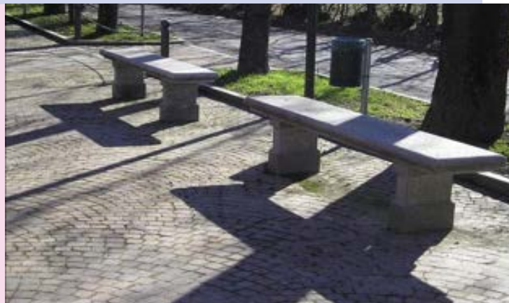
FOTO 13. Panchine fuori norma perché non utilizzabili da molte categorie di persone per la mancanza di schienale e di appoggio per il sollevamento. Molti anziani discriminati non potranno usarla in sicurezza ed autonomia. Storiche, ma anacronistiche come un WC alla turca. Anche la posizione del cestino rifiuti non è razionale in quanto non raggiungibile facilmente da una persona in sedia a rotelle o a mobilità molto ridotta.
