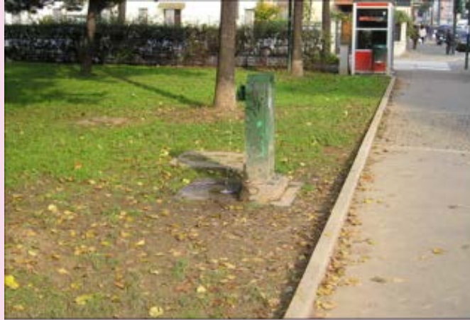
FOTO 14. Un classico Toret non identificabile dai disabili visivi e irraggiungibile dalle sedie a rotelle. L'interruzione del cordolo e l'orientamento verso il marciapiede avrebbero permesso la localizzazione della fontana ai disabili visivi e l'abbattimento gradino per i disabili motori.
