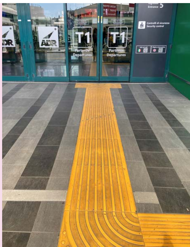
Esempio di percorso L.V.E. all'ingresso di un aeroporto
