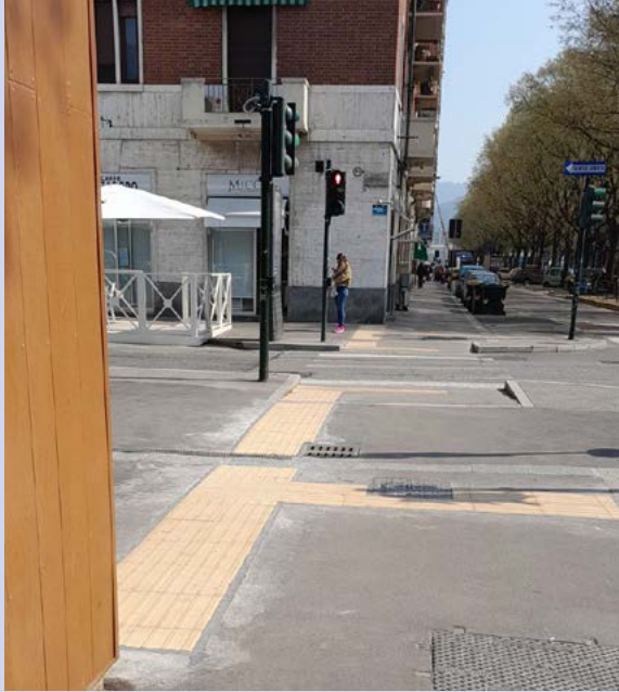
FOTO 12. Interessante e completo passaggio pedonale, con ampie distanze degli scivoli da filo muro edifici che giustificano le segnalazioni LOGES rettilinee per la guida verso il passaggio pedonale interrotto da isola spartitraffico di sicurezza dotato di segnalazioni LOGES di pericolo valicabile.
