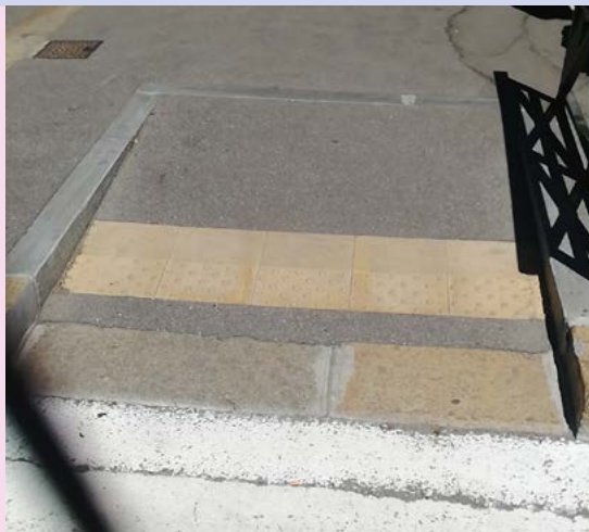
FOTO 1. Scivolo su estensione del marciapiede che impedisce il parcheggio, permette di vedere ed essere visti, dotato del segnale LOGES* di “pericolo valicabile” che facilita l'autonomia e la sicurezza di tutti - giovani ed anziani, ipovedenti e disabili motori - senza influire sulla mobilità di chi transita sul marciapiede.
