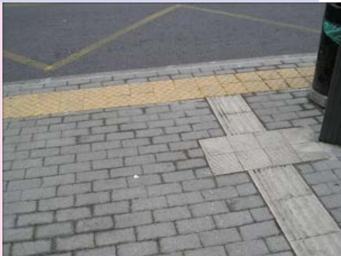
FOTO 21. La postazione di salita e discesa per le persone con disabilità Da notare l'uso di tre segnalazioni LOGES: Direzionale, Sosta, Pericolo invalicabile
